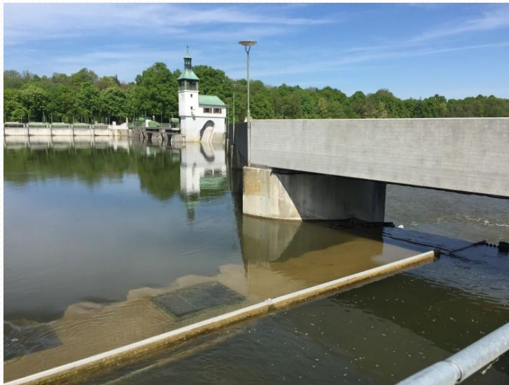
Wasserkraftwerk im Hoch- ablasswehr der Lech bei Augsburg
