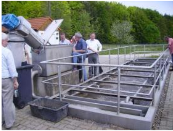
Kompaktkläranlage aus Edelstahl mit Siebrechen
