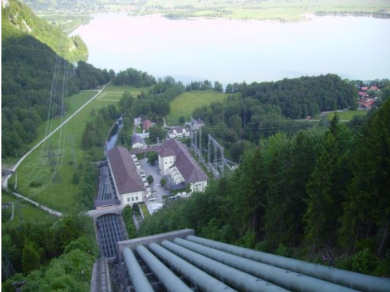
Walchenseekraftwerk mit Kochelsee
