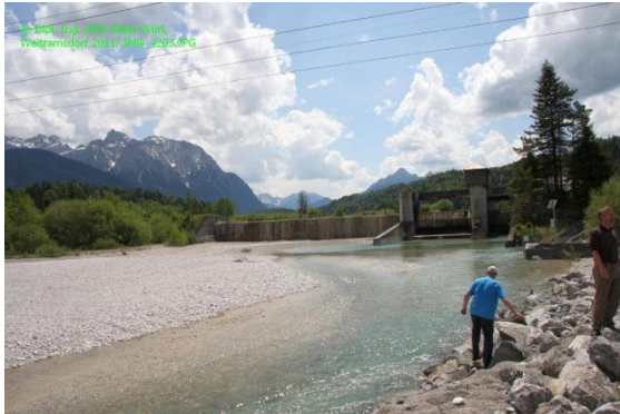
Entnahmewehr in der Isar bei Krün
