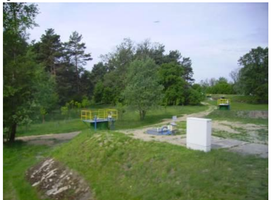
Abb. 2. Brunnengalerie für Uferfiltrat an der Warthe (Foto: Elger)
