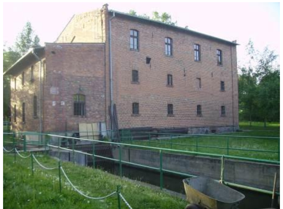
Abb. 11. Wassermühle mit Francisturbine und stehender Welle (Foto: Elger)
