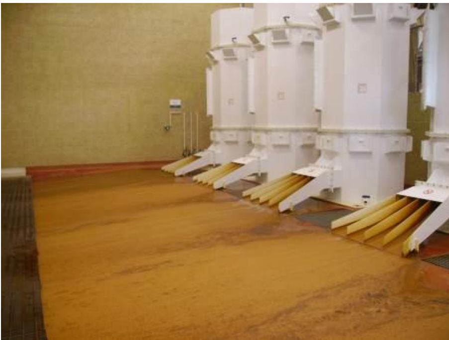
Abb. 3. Belüfter (Foto: Elger)
