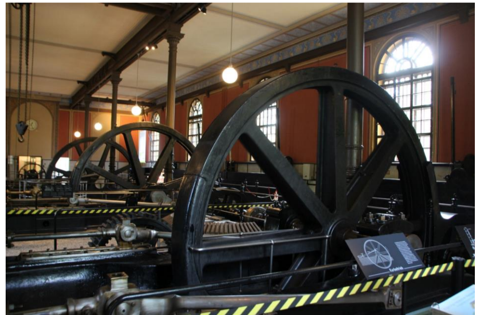
Abb. 2. Maschinenhaus des Wasserwerks
