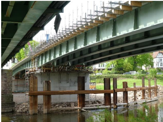
Abb. 5 : Hilfspfeiler mit Barriere
