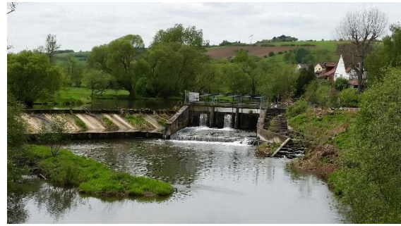
Abb. 6 : Freiflut mit Fischtreppe
