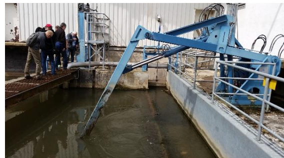
Abb.7 : Rechenanlage mit Vakuumrohr
