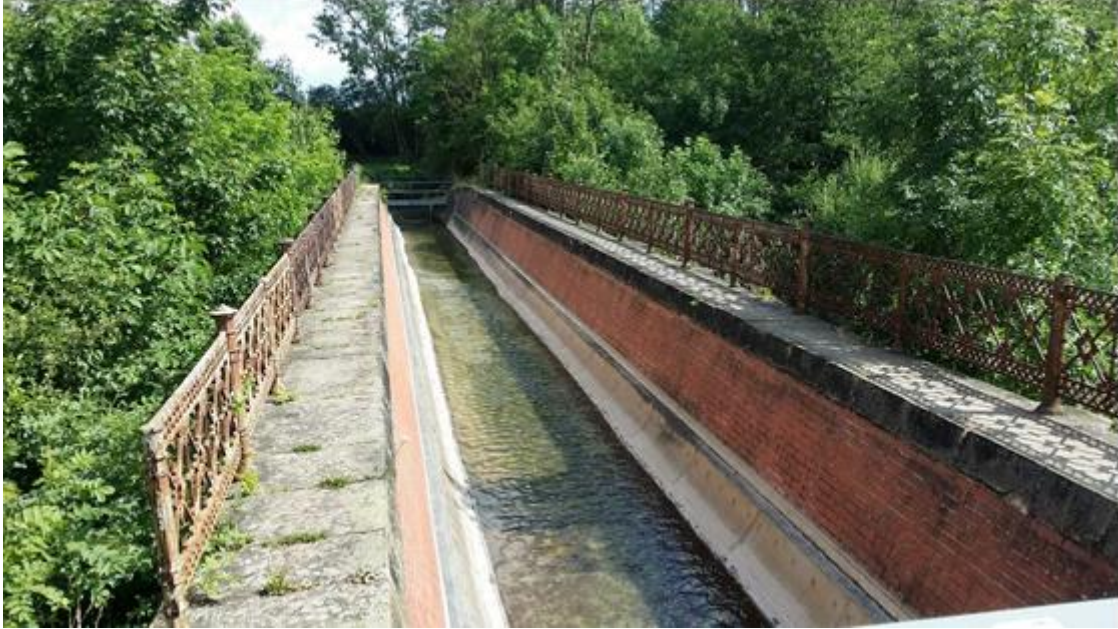
Bild 4 Aquädukt Foto: Elger
